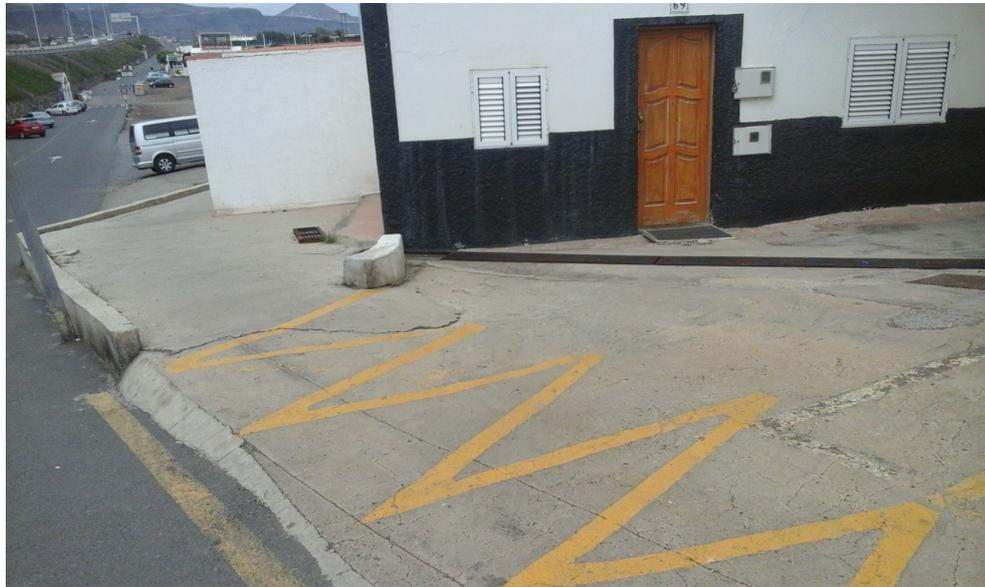
**Foto Nº2. Detalle del Imbornal a restituir en la acera del margen derecho, en el inicio de la actuación.**
