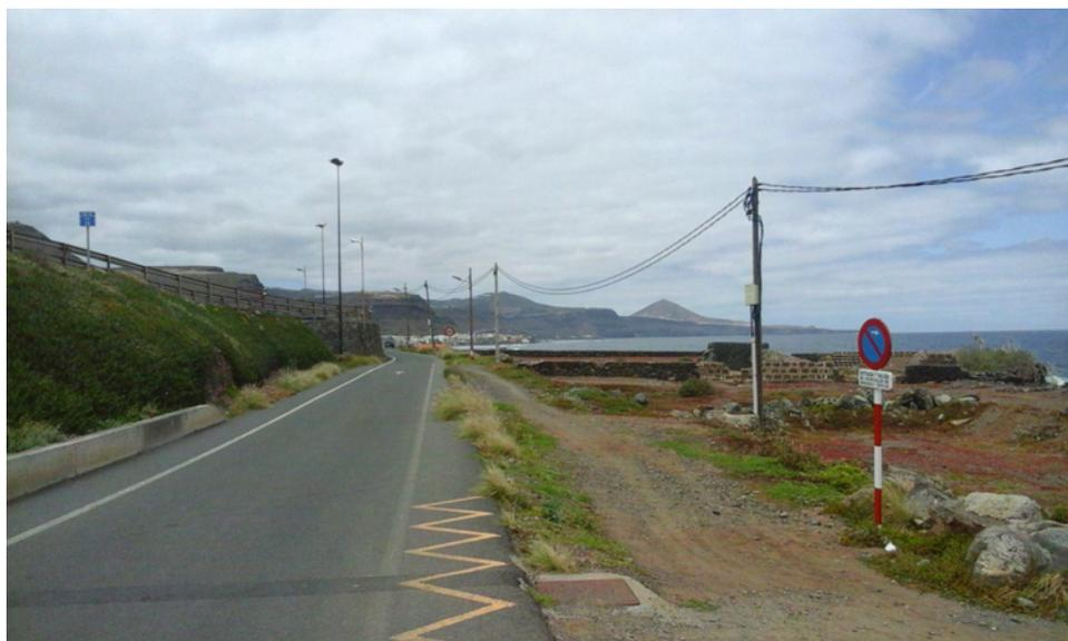
**Foto N°13. Vista general del final de la actuación, en la zona de ubicación de la glorieta. Obsérvese los postes de líneas aéreas de distintos servicios a soterrar.**
