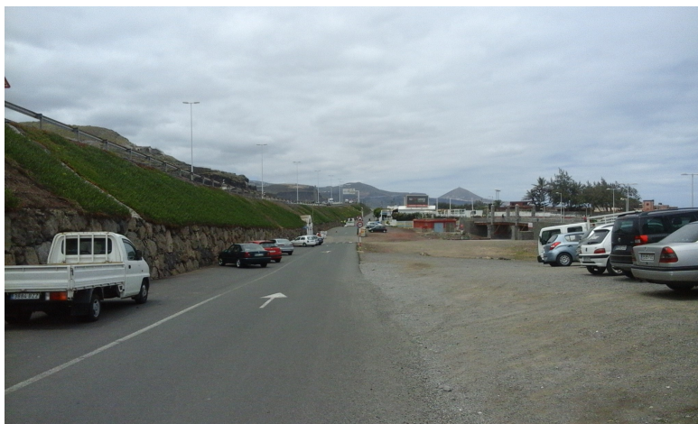
Vista general del vial de servicio.
